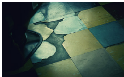
剥がれたタイルもここでは様になっている。
