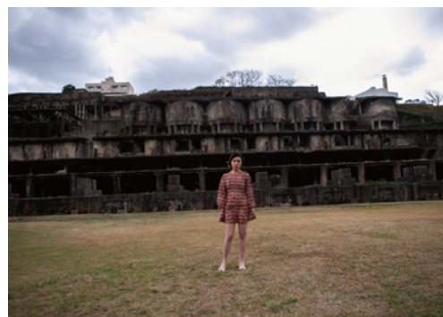
▲斜面にはコンクリートの建造物が城壁のように並ぶ
